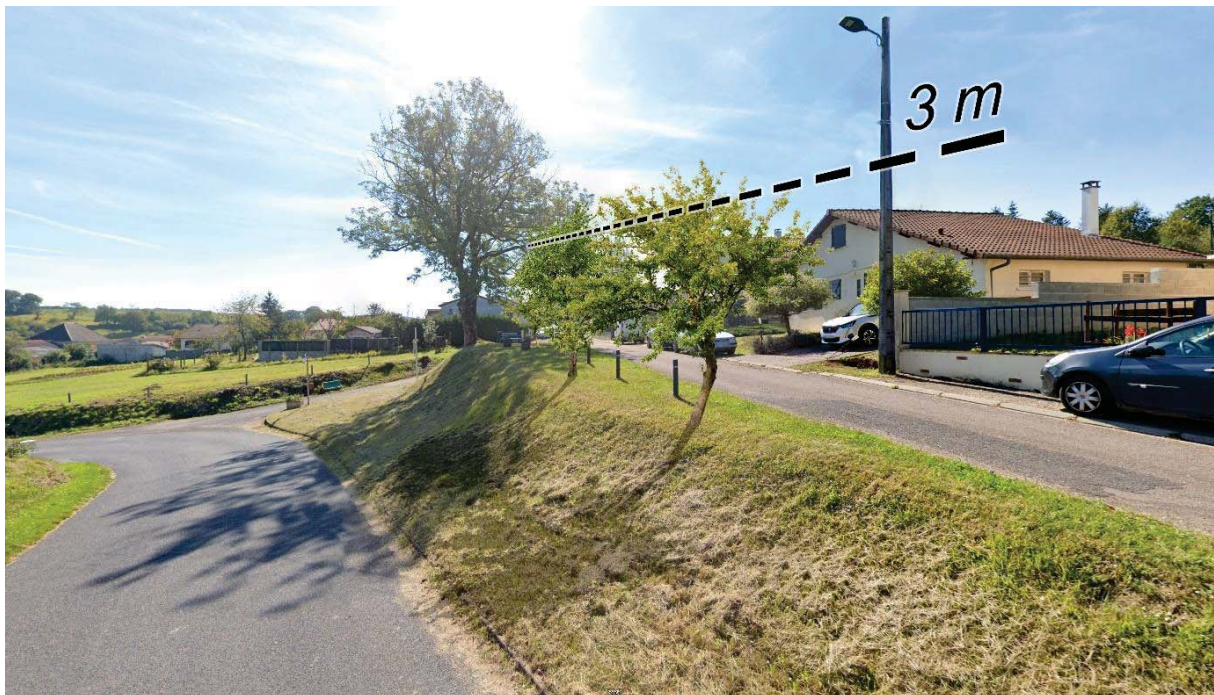
Photo 3 : Modélisation de la mesure à 3 m de hauteur, avec la mesure d'enfouissement des lignes aériennes – au croisement entre la route de Seigneulles et la rue de la Varenne, à Erize-la-Brûlée (Source : BE JC)
